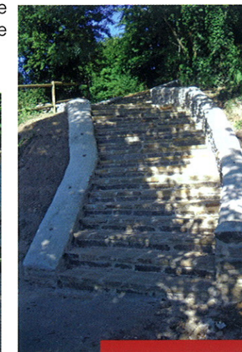
Escalier en cours de restauration
